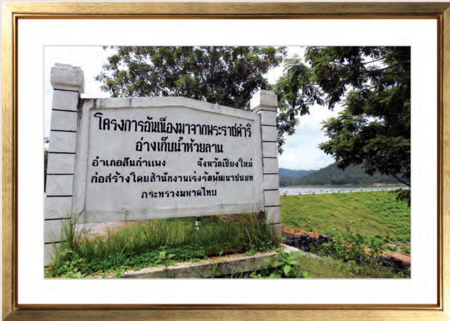
ภาพที่ 3.2 หน่วยงานก่อสร้างอ่างเก็บน้ำ
