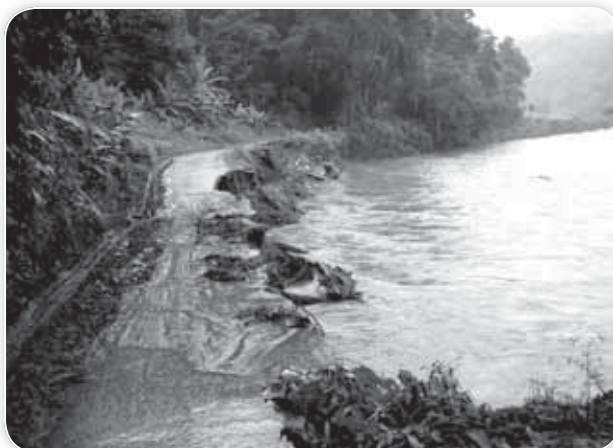
รูปที่ 4.11 เส้นทางเข้าสู่อุทยานแห่งชาติแม่เงาถูกน้ำป่า และแม่น้ำเงากัดเซาะ เดือนสิงหาคม 2551
