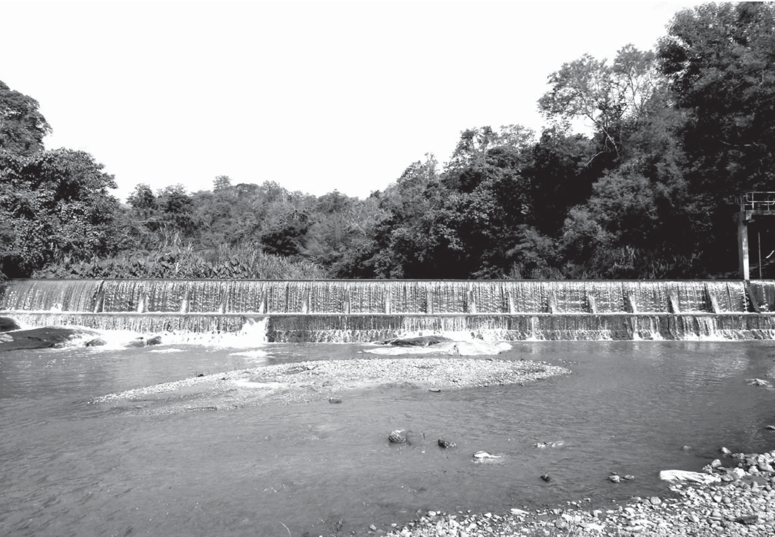
ภาพที่ 6.5 ฝายนอนกั้นแม่น้ำว้าง ตำบลบ้านกาด อำเภอแม่วาง
