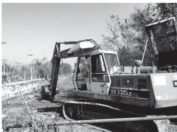
ภาพที่ 4.8 การขุดลอกลำเหมืองเจ้าสีหมื่น
